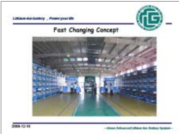
Batteriewechselstation in der Batteriehalle
