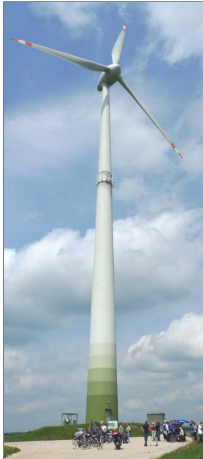
2,5 MW Enercon Windkraftanlage in Kasberg
