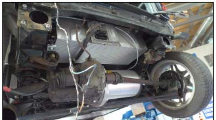
Während am ersten Tag hauptsächlich die nicht mehr benötigten Teile ausgebaut wurde, kam relativ schnell der Elektromotor und die Steuerung rein. Später folgten die Batterien und viel Zeit nahm dann die Verkabelung und schrittweise Inbetriebnahme ein.
