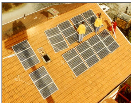
Bau der vereinseigenen 3,3 kW Anlage. Die Anlage wurde 2002 um 5,1 kW ergänzt auf zur Zeit rund 8,4 kW Gesamtleistung
