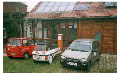
Solartankstelle des Vereins, rechts oben ein Teil der 1,2 kW Solaranlage
