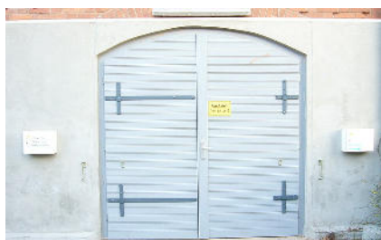
Rechts und links vom Werkstattort die abgeschlossenen Metallboxen mit je 11 kW Anschlussleistung für die E-Fahrzeuge der Vereinsmitglieder.
