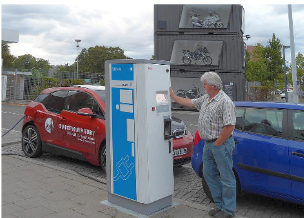
Endlich nach 156 km am BMW Motorrad Werk Spandau einer einer 50 kW CCS Schnellladesäule. Nach nur 24 Minuten gings weiter.
