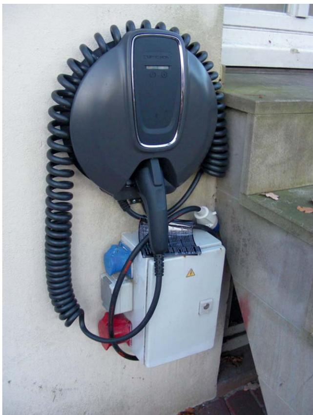
Drehstromkiste mit Opel Wallbox – mit 16 A einphasig mit Typ1-Stecker laden
