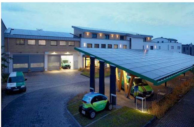
Ladepark Kreuz Hilden mit insgesamt 14 Ladeplätzen zum Aufladen von E-Mobilen. Dort können 28 Anschlüsse (14 x Typ 2 bis 32 A und 14 x Schuko mit 16 A) genutzt werden, um sauberen Strom zu laden.
