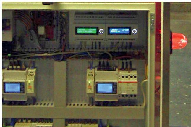
Die beiden SDM630 Zähler hängen jetzt gemeinsam an einem RS485 Anschluß am Raspi. Auswerten kann ich sie schon. Jetzt muß ich noch ein klein wenig in die Programmierung einsteigen, damit das Rechenwerk mit Daten versorgt wird und damit die Power-LED je nach Leistung "Rot" anzeigt.
