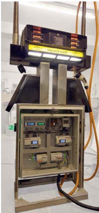
Carsten hat sich viel Mühe gegeben. Denn nicht nur die Platine im Schaltschrank musste verdrahtet werden, auch der Rest der Säule will angeschlossen sein. Die dicke Zuleitung für maximal 63A geht natürlich auch gleich an den Leitungsschutzschalter. Das gibt dicke Oberarmmuskeln.
