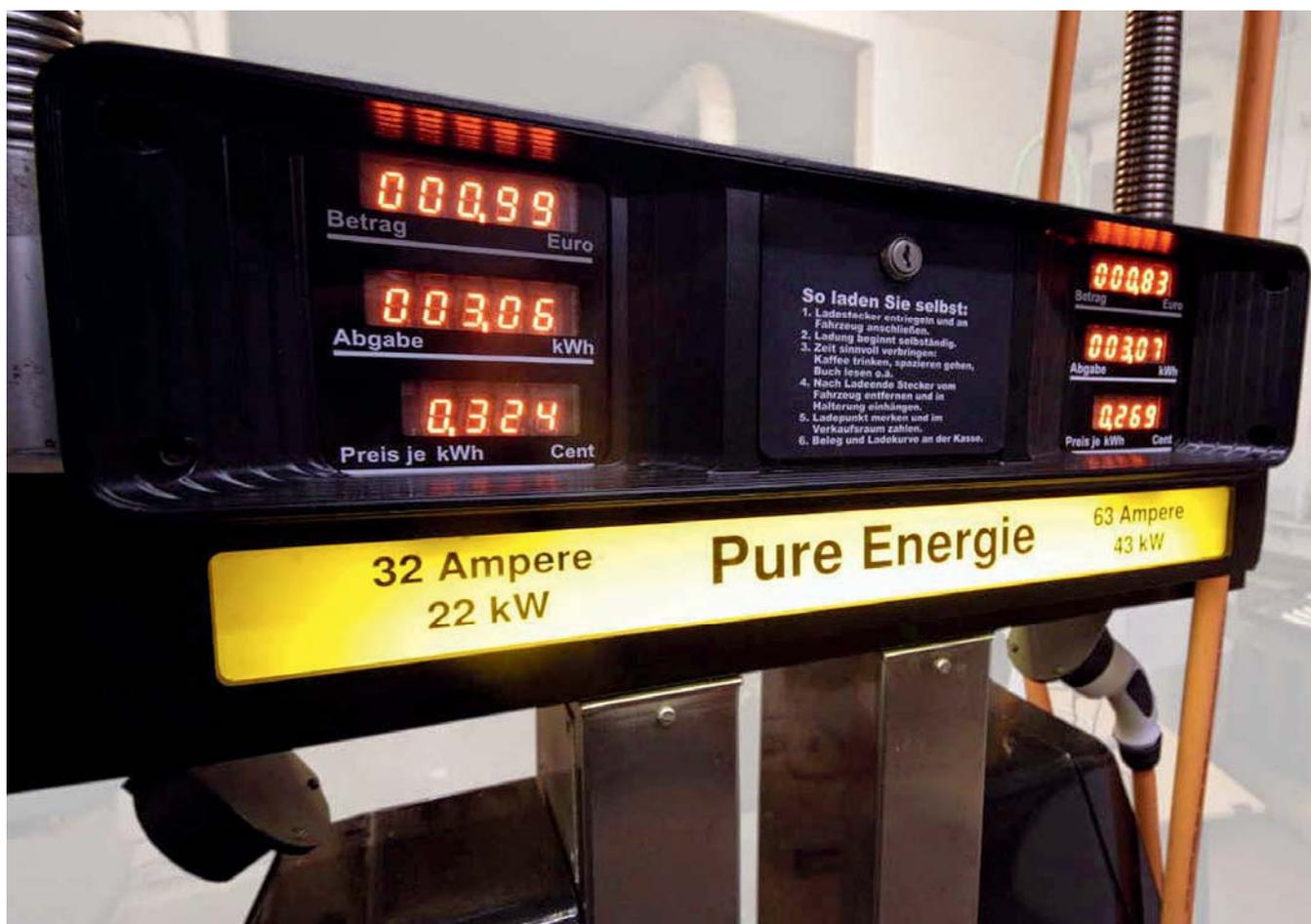
Die betriebsbereite Doppelsäule mit 22 kW Anschluß links und 43 kW Anschluß rechts.
