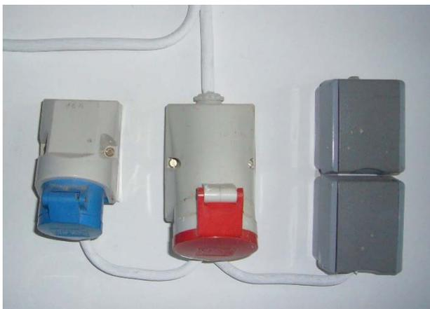
Außensteckdosen mit CEE-blau einphasig 16A, CEE rot dreiphasig 16A und zweimal Schuko Steckdosen, gesamt Belastung bis zu 11 kW
