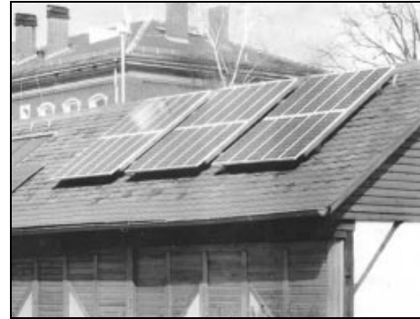
1,1 kW Anlage, Solarmobilverein Erlangen
