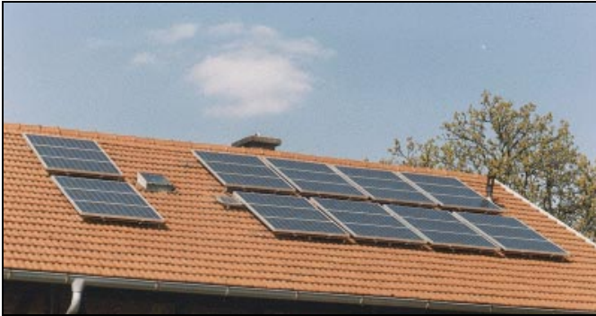
3,3 kW Anlage auf dem Dach, Solar Energie Werk Erlangen
