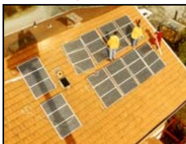
Bau der vereinseigenen 3,3 kW Anlage. Die Anlage wurde 2002 um 5,1 kW ergänzt auf zur Zeit rund 8,4 kW Gesamtleistung
