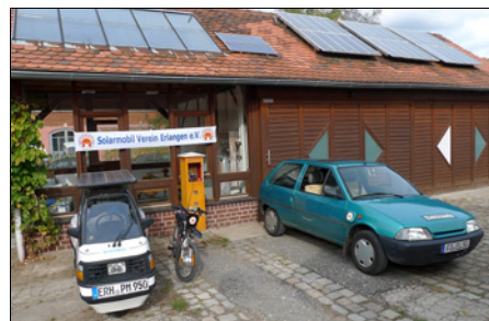
Solarstromtankstelle am 8.10.2009, rechts oben die 1,1 kW Photovoltaikanlage des Solarmobil Vereins
