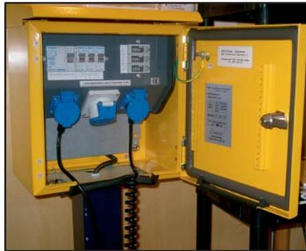
Herkömmlich Park&Charge Stromtankstelle in Deutschland mit drei einphasigen Steckdosen, davon einmal CEE blau, FI-Schalter, Sicherungsautomaten und drei Stromzählern.
